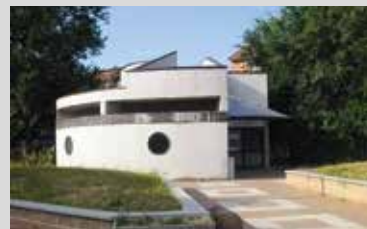
La struttura della scuola Don Zeno
