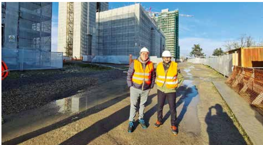
Il Sindaco e l'Assessore Rogliani nel cantiere di Via delle Rose
