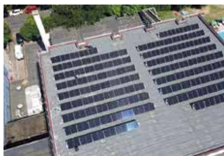
Nuovi pannelli fotovoltaici sul tetto della piscina
